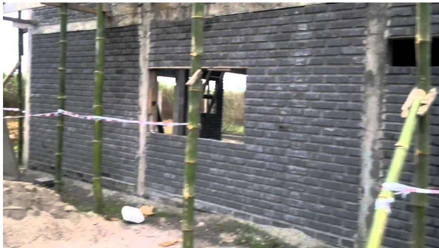
Gráfico No. 6. Mampostería realizada con ladrillos de ceniza de bagazo de caña de azúcar en la República de Argentina.
