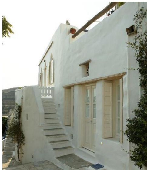
Gráfico No. 8. Mampostería revestida con cal y arena en la República Helénica.
