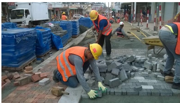
Gráfico No. 37. Adoquinamiento de la Calle 13. Ciudad de Manta, República del Ecuador.
