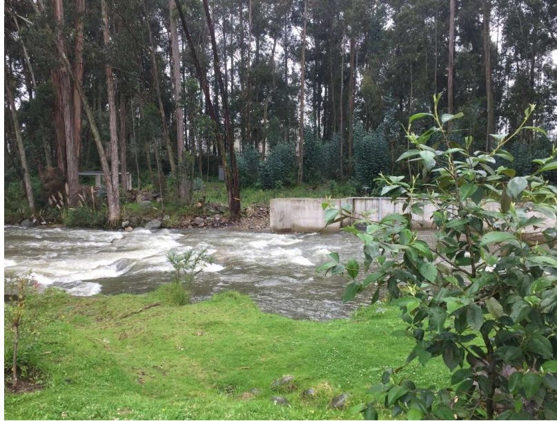
Gráfico No. 19. Planta de procesamiento donde se ubica la turbina mino hidro de 5kw situada en el río Tomebamba siendo utilizado como generación de energía en épocas de invierno. Cantón Cuenca. Provincia Azuay. Fuente: Fotografía realizada por los autores de este análisis de caso. [10, mayo, 2018].
