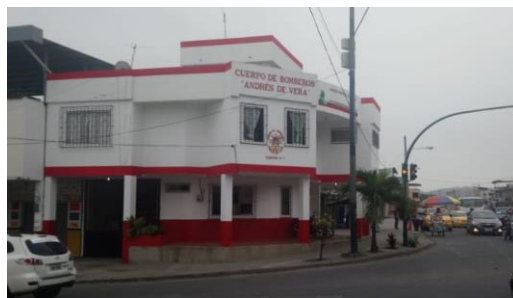
Gráfico N°. 71. Fachada principal y acceso de los vehículos de la sub-estación de cuerpo de Bomberos de la parroquia Andrés de Vera. Fotografía tomada por auxiliares de este análisis de caso. [20, mayo, 2018].
