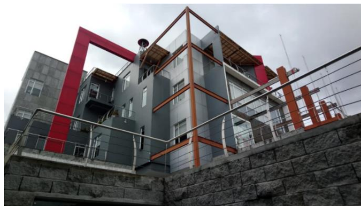
Gráfico N°. 18. Fotografía de la fachada posterior del edificio administrativo del cuerpo de Bomberos de la Ciudad de Cuenca, Provincia de Azuay; República del Ecuador. Fotografía tomada por los autores de este análisis de caso. [16, mayo, 2018].
