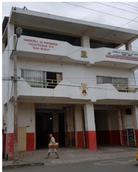
Gráfico N°. 47. Fachada principal y acceso de los vehículos de la sub-estación de Bombero de la parroquia San Pablo, ciudad de Portoviejo, Provincia de Manabí; República del Ecuador. Fotografía tomada por auxiliares de este análisis de caso. [20, mayo, 2018].
