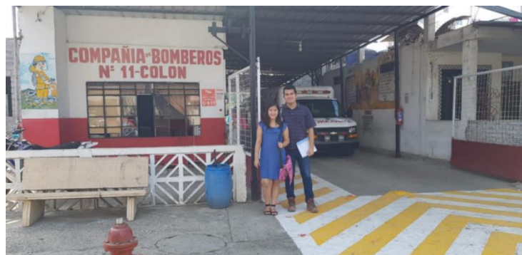
Gráfico N°. 100. Fachada principal y acceso de los vehículos de la sub-estación de Bomberos de la parroquia Colón en la ciudad de Portoviejo, provincia de Manabí; República del Ecuador. Fotografía tomada por auxiliares de este análisis de caso. [20, mayo, 2018].
