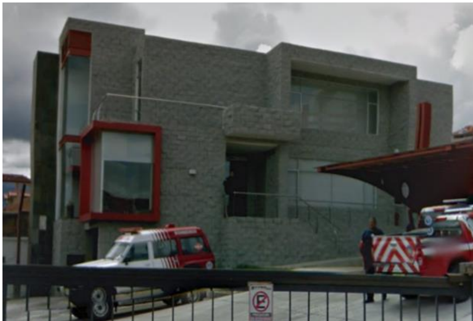
Gráfico N°. 19. Fotografía de la fachada de la Estación N° 5 del Cuerpo de Bomberos de la Ciudad de Cuenca, Provincia de Azuay; República del Ecuador. Fotografía tomada por los autores de este análisis de caso. [16, mayo, 2018].
