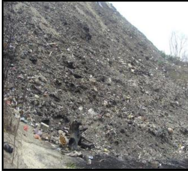
Acarreo de desechos hacia la quebrada adyacente al lugar de disposición.
