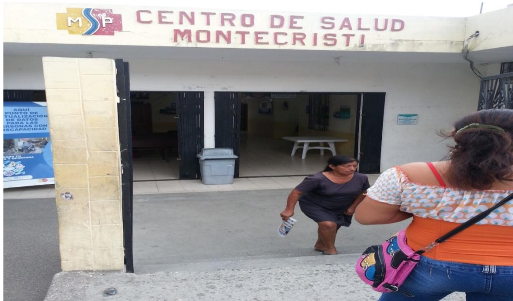
Gráfico N° 8. Vista exterior de la infraestructura del Centro de Salud Montecristi. Realizado por Daniela Mercedes Morales Álava la Autora de la tesis. Anexo 4. p. 70.
