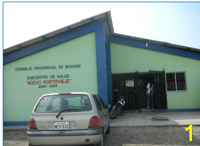
Foto N° 1. Subcentro de salud Nuevo Portoviejo.
