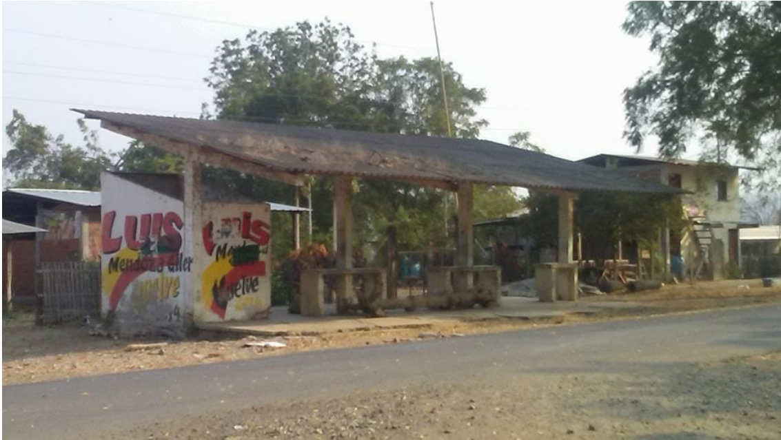
Gráfico N°. 76. Foto de la infraestructura vial principal, comunidad Montañita del cantón Junín, Provincia de Manabí. República del Ecuador. Fotografía realizada por los autores del análisis de caso. [2018].
