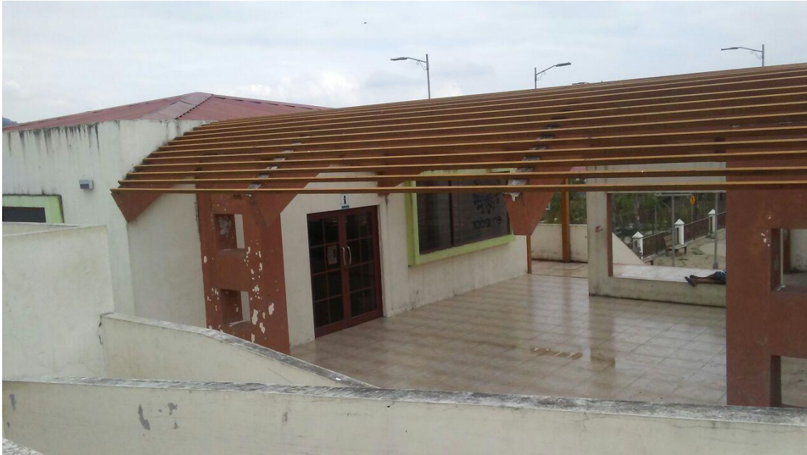
Gráfico N°. 51. Foto del equipamiento de salud en la comunidad de la Tablada de Sánchez, Parroquia Santa Rita en el cantón Chone, Provincia de Manabí, República del Ecuador. Fotografía realizada por los autores de este análisis de caso. [2017].
