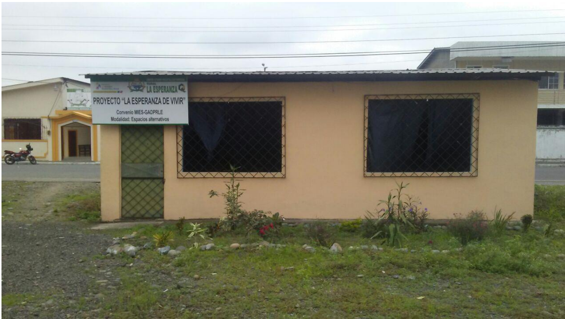
Gráfico N°. 36. Foto del equipamiento comunitario, de la parroquia Rural La Esperanza del cantón Quevedo, Provincia de los Ríos. República del Ecuador. Fotografía realizada por los autores del análisis de caso. [2017].
