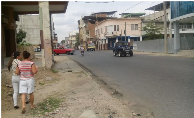
Ilustración 96. Aceras en mal estado y con obstáculos para el peatón. Portoviejo. República del Ecuador. Fuente: Fotografía realizada por los autores de este análisis de caso.
