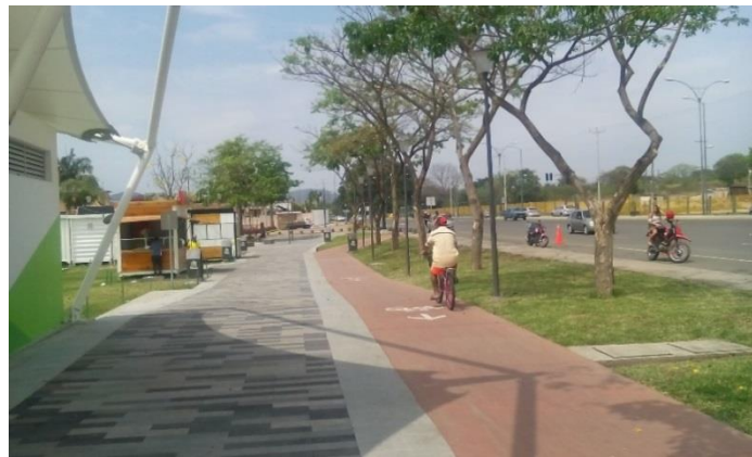
Ilustración 59. Ciclovía interna. Foto parque la Rotonda de Portoviejo. República del Ecuador. Fuente: Fotografía realizada por los autores de este análisis de caso.
