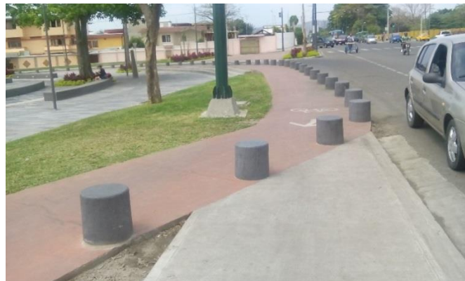
Ilustración 60. Falta de continuidad hacia la acera de la Avenida Urbina por el recorrido de la ciclovía. Foto parque la Rotonda de Portoviejo. República del Ecuador. Fuente: Fotografía realizada por los autores de este análisis de caso.
