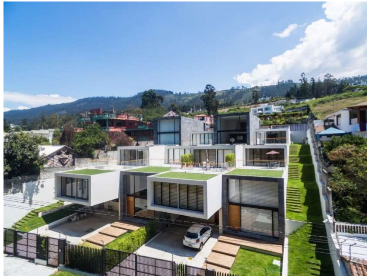
Gráfico No. 44. Vista exterior del proyecto (2017). [En línea]. Consultado: [13, noviembre, 2017]. Disponible en: https://www.plataformaarquitectura.cl/cl/877367/casas-ff-tec-taller-ec/598a707eb22e38dac6000339-ff-houses-tec-taller-ec-photo
