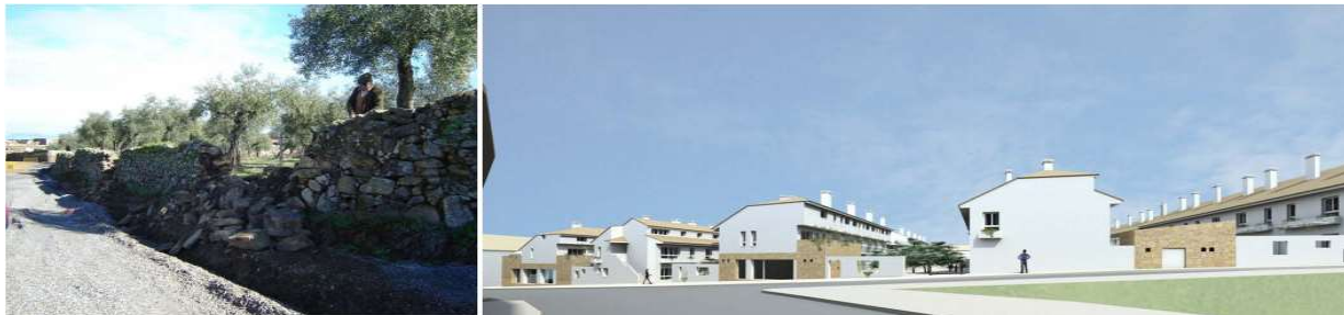
Gráfico No. 6. Cerca de piedra existente y Vista fachada oeste con piedra de la cerca del solar recuperada en muros- conjunto residencial bioclimático entre olivos-Desarrollo P. (S/F). [En línea]. Consultado: [07, noviembre, 2017].
