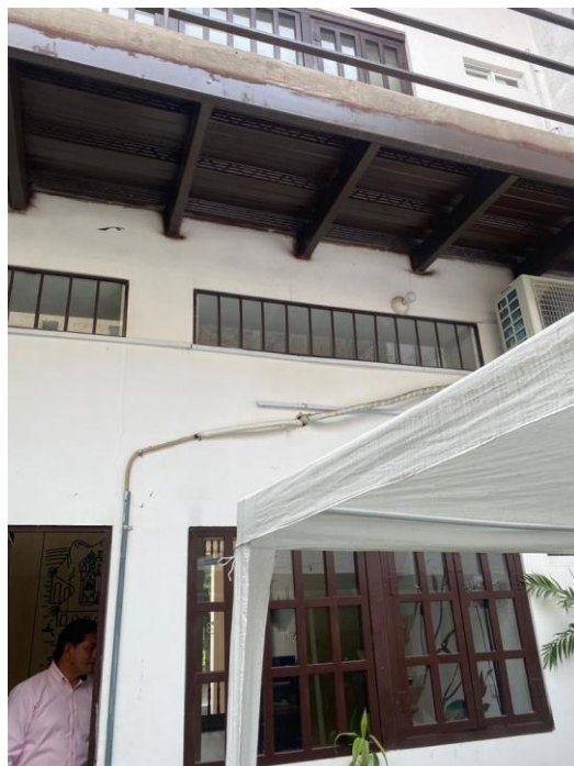
Anexo B4, vista de estructura metálica en planta alta
