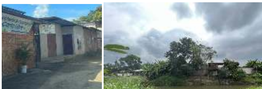
FIGURA 16: Edificaciones existentes dentro del área de protección
