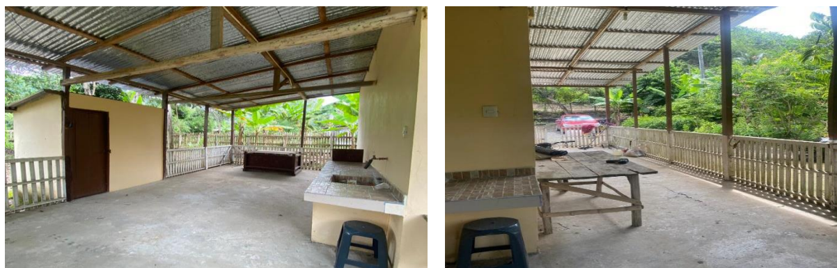
Figura 98. Estado actual de los espacios internos de la vivienda N° 5.
