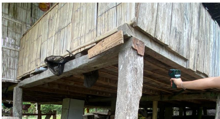
Figura 13. Verificación y recolección de datos in-situ de la vivienda de “Los Tres Espacios” de la familia García Intriago.
