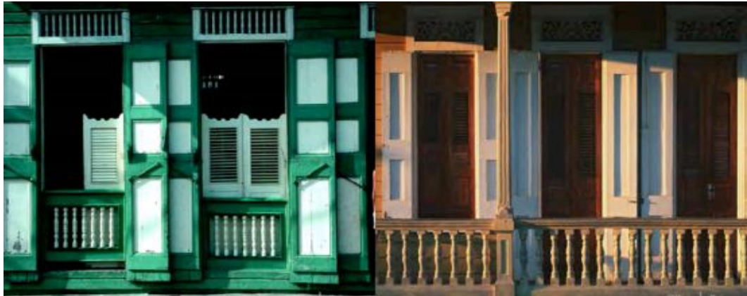
Gráfico N°.12. Sistema de ventilación doble de una vivienda vernácula dominicana, República Dominicana. [En línea].
