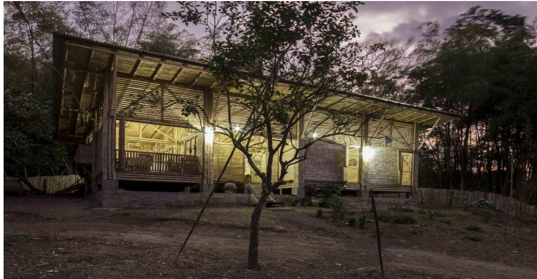
Gráfico N°.65. Casa vernácula en parroquia Convento, República del Ecuador. [En línea]. Consultado: [2017, julio 10]. Fuente: Disponible en línea: https://www.domestika.org/es/projects/159975-casa-de-bambu-en-manabi-ecuador-arquitectura-vernacula
