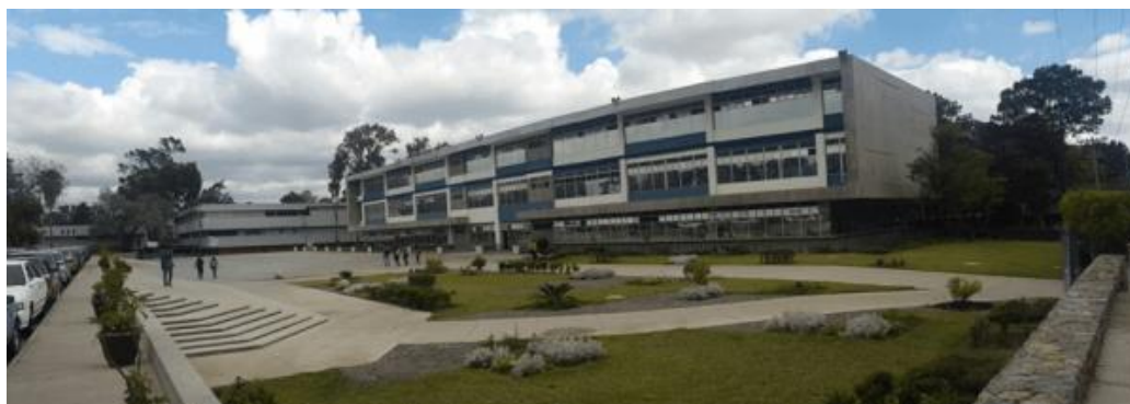
Gráfico No. 9. Edificio DIGA Universidad de San Carlos de Guatemala. Guatemala.
