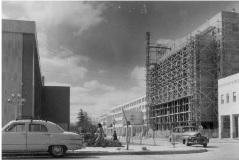
Gráfico No. 16. Vista del eje cívico desde Avda. Rioja hacia el este. En primer plano, a la izquierda, el Banco de la Nación Argentina; a la derecha, el Banco Hipotecario Nacional, en construcción (Archivo fotográfico del arquitecto Nemecio Nieto). Laciari, M. Nieto, A. Rosés, E. y Manzur, J. (2012). eje cívico y Arquitectura institucional moderna en la ciudad de san Juan, Argentina su planificación y concreción post-terremoto de 1944. San Juan. República Argentina: Universidad Nacional de San Juan.
