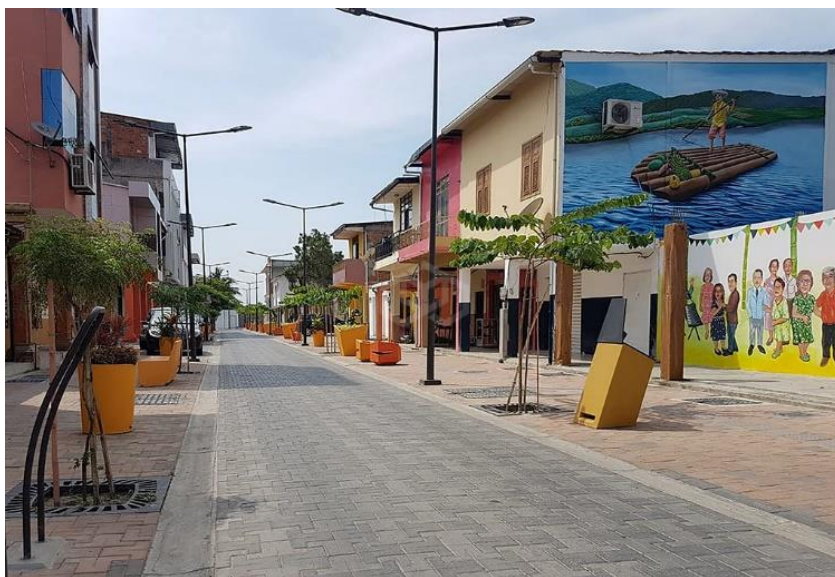
Figura 6. Regeneración urbana del centro urbano de Portoviejo
