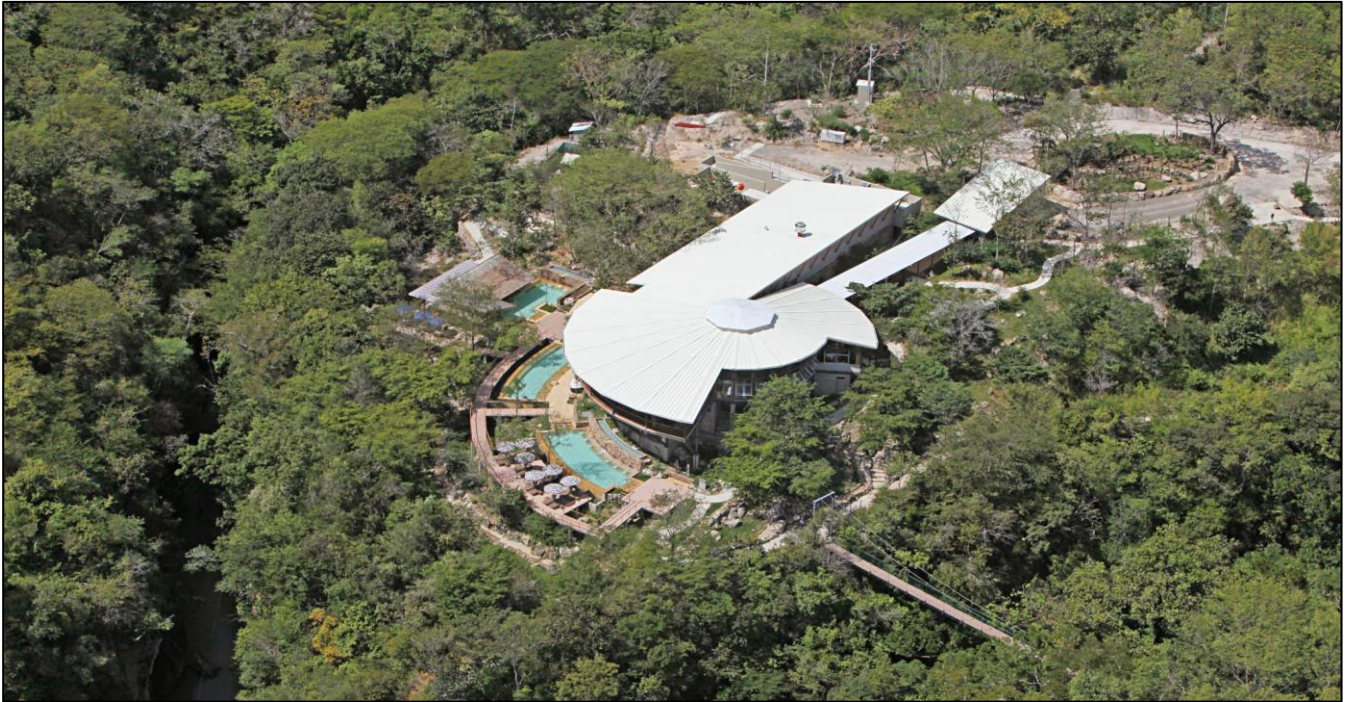
Figura 24 Quinta fachada de la estructura principal
