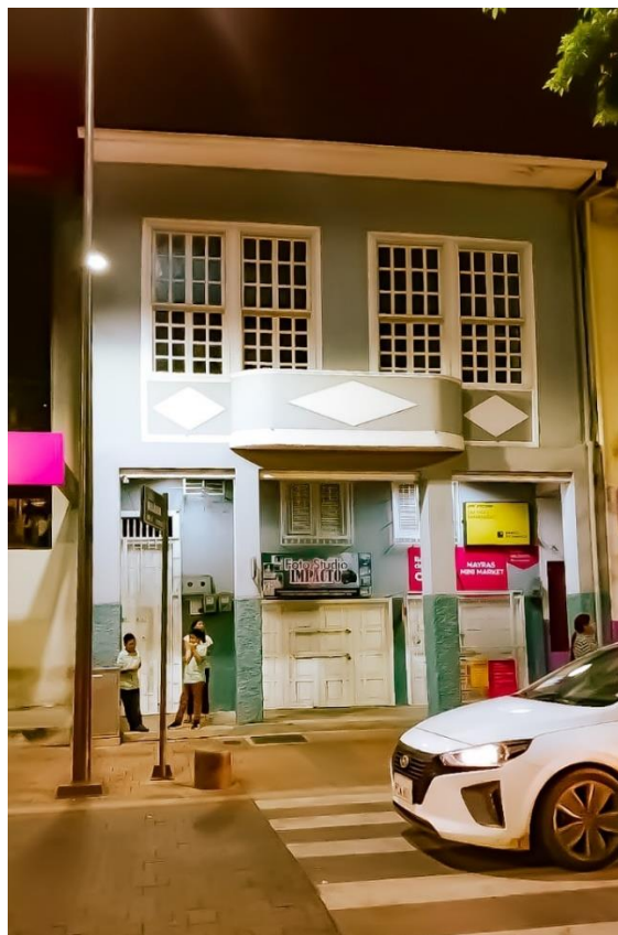
Ilustración 21 Fotografía actual de Casa Cedeño Ubillus. (Eche M., 2022).
