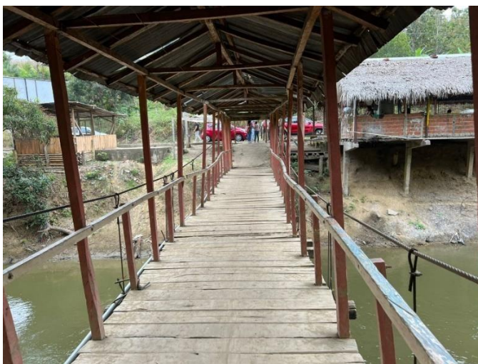
Puente Peatonal del Balneario “La Lucha”
