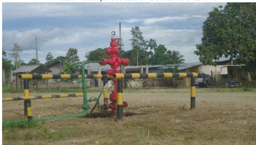
Figura 12 Plataforma con pozo ubicada en la Ciudad de Shushufindi
