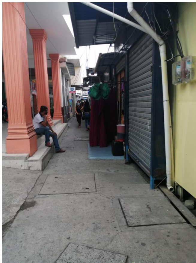
Figura 10 Evidencia deterioro del espacio público Elaborado por: El Investigador
