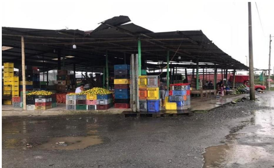
*Nota:* La infraestructura, su cubierta en mal estado, así como su estructura de caña. Fotografía propia. (2021)
