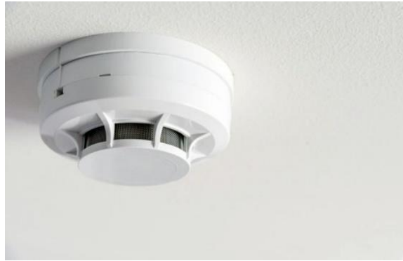
Figura 15. Sistemas detectores de humo
