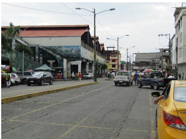
Mercado del Río vista exterior y calle del malecón
