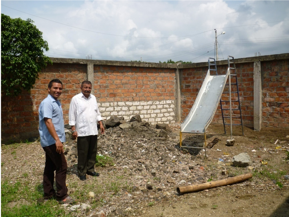
Terreno para construcción del departamento de odontología
