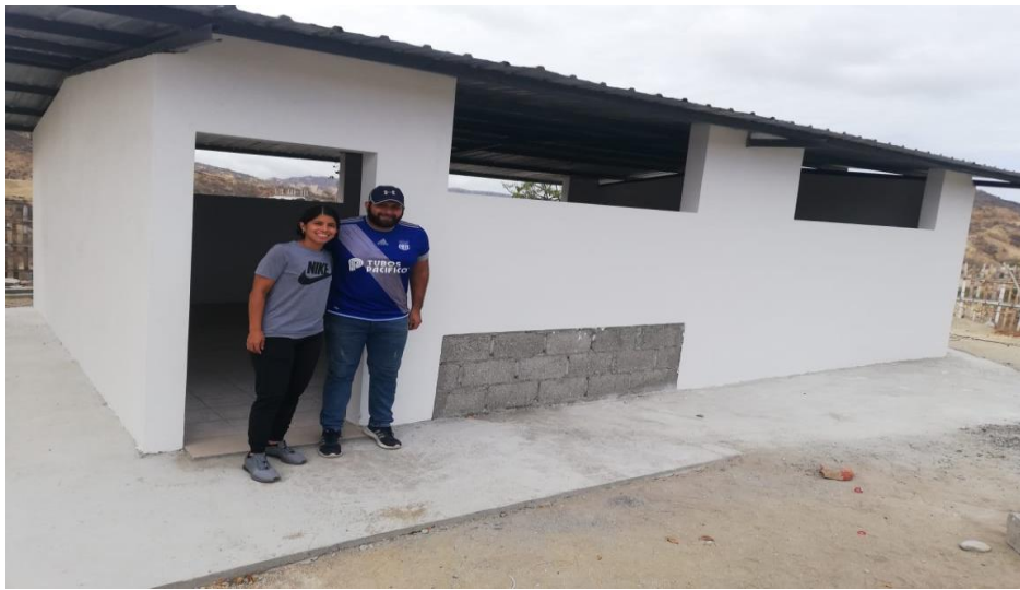
Gráfico No. 94. Fachada principal del aula de computación elaborada con bloques de plásticos PET. (2020). Fuente: Fotografía tomada por el auxiliar de este análisis de caso.
