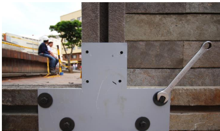
Gráfico No. 4. Ensamblaje de la estructura de los bloques de plásticos (2017). Fuente: bloqueplas. [En Línea]. Consultado: [11, diciembre, 2019] Disponible en: http://bloqueplas.com/index.php/medios/galeria
