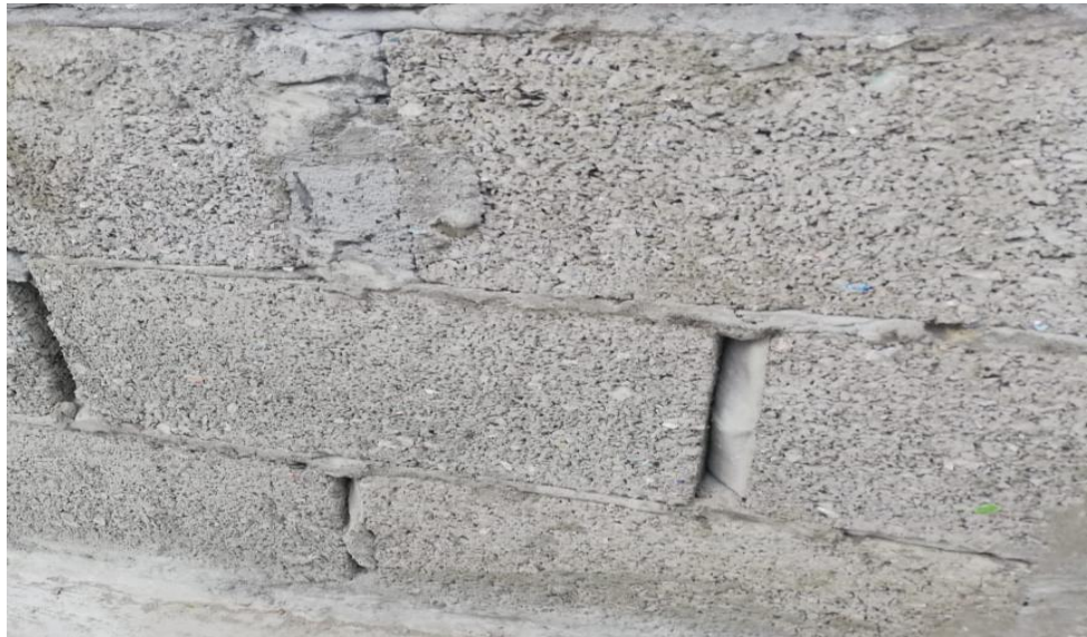
Gráfico No. 95. Pared del aula de computación elaborada con bloques de plásticos PET. (2020). Fuente: Fotografía realizada por los autores de este análisis de caso.
