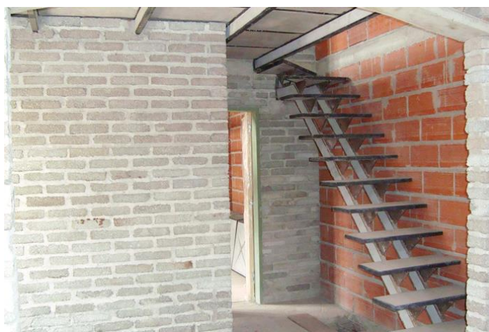
Gráfico No. 8. Mampostería de hormigón y plástico PET (2019).
