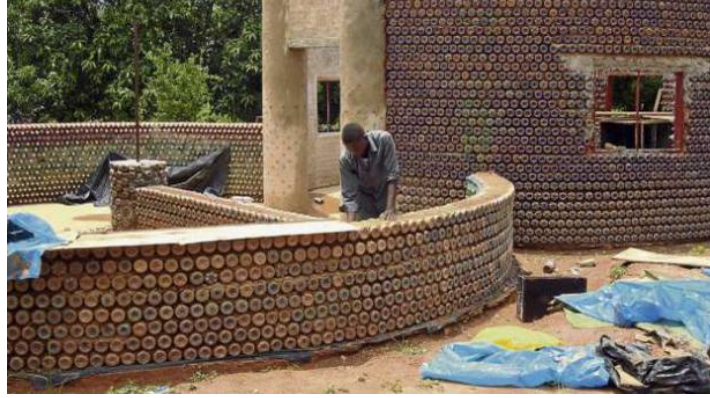
Gráfico No. 9. Armado del sistema constructivo con botellas de plástico rellenas de arena. Fuente: Diario El Comercio. [En Línea]. Consultado: [11, diciembre, 2019] Disponible en: http://www.elcomercio.com/tendencias/construir/botellas-de-
