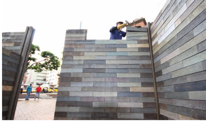
Gráfico No. 3. Unión de los bloques de plásticos.
