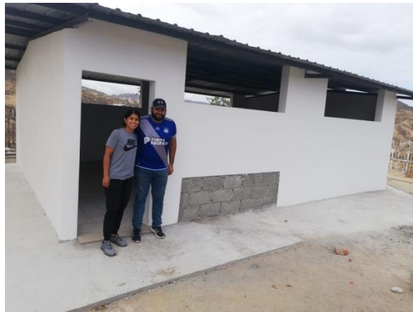
Gráfico No.11. Fachada frontal. Cantón Manta. Provincia de Manabí. Fuente: Fotografía realizada por el auxiliar de este análisis de caso. [06, Febrero, 2020].
