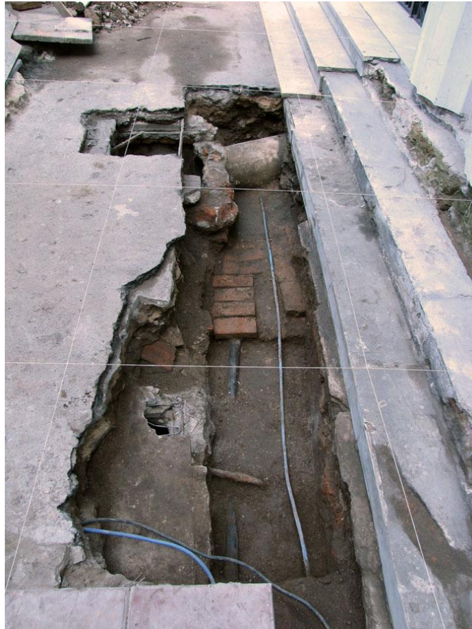
Gráfico No.11. Imagen de la excavación mostrando los escalones enterrados y el sistema de desagüe antiguo del Cementerio de la Recoleta , Buenos Aires – República Argentina [En Línea]. Consultado: [08, Enero, 2020]. Disponible en: https://travesiasdigital.com/destinos/cementerio-de-la-recoleta
