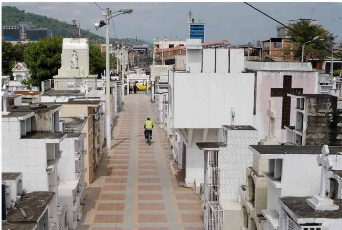
Gráfico No.29. Acceso peatonal y en sus laterales los cuerpos de bóvedas del Cementerio Municipal de Portoviejo, Provincia de Manabí – República del Ecuador. [En Línea]. Consultado: [22, Enero, 2020]. Disponible en: https://www.google.com/search?q=cementerio+de+portoviejo&source=lnms&tbm=isch&sa=X&ved=2ahUK Ewi2842JpL3nAhWglXIEHdsiCDcQ_AUoAXoECA0QAw#imgrc=SyzKeBAma-n7mM&imgdii=Tk-9JO9qETAMMM .
