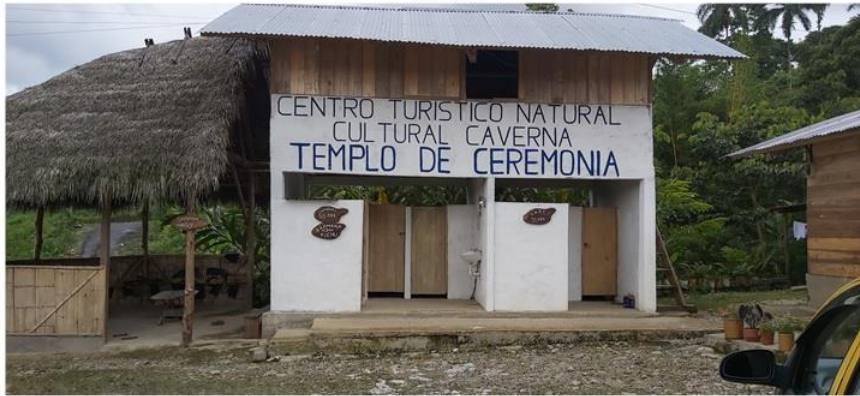
Baterías sanitarias y lugar de vestidores y cambio de zapatos para iniciar el recorrido
