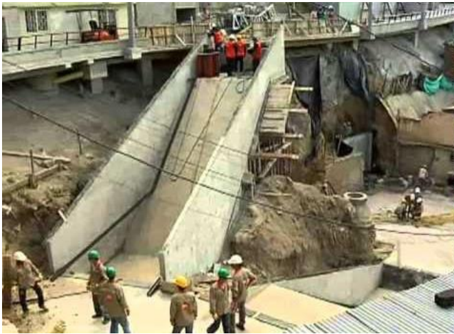
Gráfico No.5: Proceso de construcción de las escaleras eléctricas en barrio de Medellín.
