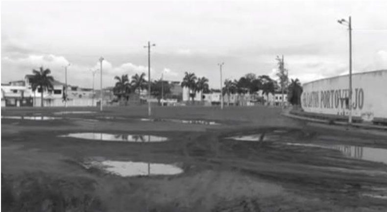
Gráfico No.22: Mal estado en su antigua infraestructura (Parque La Rotonda antes). [En línea]. Consultado: [24, Noviembre del 2019]. Disponible: https://www.facebook.com/watch/?v=1550241415013974 Editado: Autores de análisis de caso.
