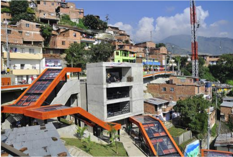
Gráfico No.6: Espacios externos de las escaleras eléctricas en barrio de Medellín.[En línea]. Consultado: [24, Noviembre del 2019]. Disponible: https://www.plataformaarquitectura.cl/cl/788628/5-ciudades-que-destacan-por-sus-planes-de-innovacion-urbana/574e5c9de58ece8b06000127-5-ciudades-que-destacan-por-sus-planes-de-innovacion-urbana-foto
