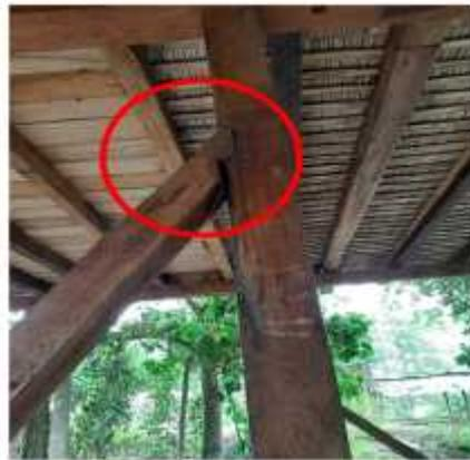
ENSAMBLE EMPALETADO USADO EN CONCRETES O DIAGONALES
