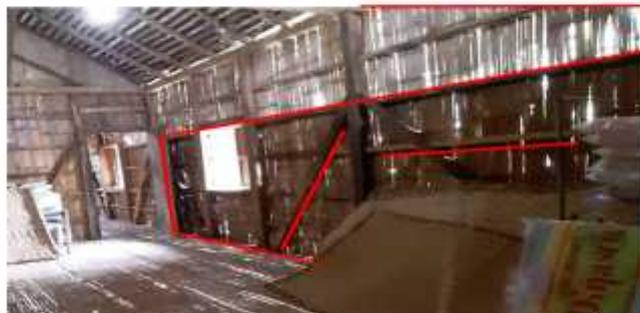
**PAREDES CON DOBLE RECUBRIMIENTO DE CAÑA PICADA
