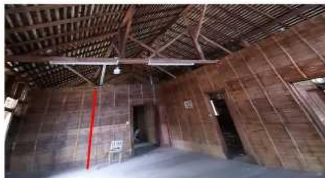
**PAREDES DE CAÑA PICADA CON LATILLAS COLOCADAS EN
