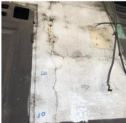
Gráfico No. 11. Mampostería exterior deteriorada de la vivienda Viteri Guerrero de Portoviejo, provincia de Manabí. República del Ecuador. [20, junio, 2019].
