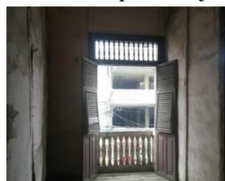
Ilustración 47: Ventanerías tipo chaza de la Casa Viteri. (INPC, 2017)
