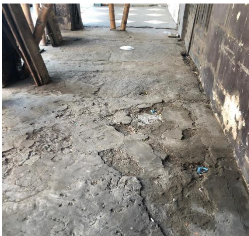
Gráfico No. 18. Suelo desgastado de la vivienda Viteri Guerrero de Portoviejo, provincia de Manabí. República del Ecuador. [20, junio, 2019].
