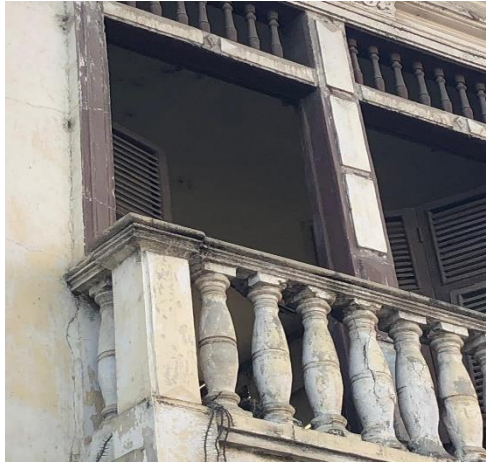
Gráfico No. 10. Deterioro de ventanas de la vivienda Viteri Guerrero de Portoviejo, provincia de Manabí. República del Ecuador. [20, junio, 2019].
