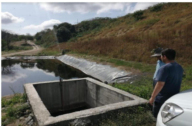
Gráfico No 28. Celda de Residuos sólidos, piscina de lixiviados del Relleno Sanitario. Portoviejo. República del Ecuador. Foto tomada por los autores del caso. [11, Julio, 2019].
