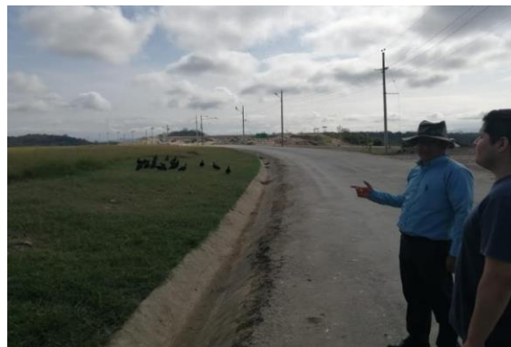
Gráfico No 32. Celda de Residuos sólidos, vía interna con canaletas para aguas lluvias del Relleno Sanitario. Portoviejo. República del Ecuador. Foto tomada por los autores del caso. [11, Julio, 2019]
