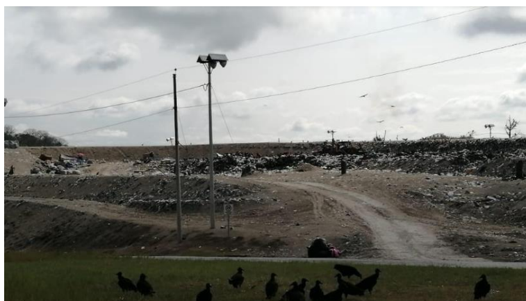
Gráfico No 29. Celda de Residuos sólidos, área de encapsulamiento de residuos del Relleno Sanitario. Portoviejo. República del Ecuador. Foto tomada por los autores del caso. [11, Julio, 2019]
