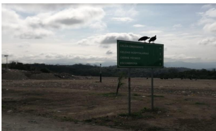
Gráfico No 23. Celda de Residuos sólidos, ingreso al área de parqueo improvisada del Relleno Sanitario. Portoviejo. República del Ecuador. Foto tomada por los autores de este análisis de caso. [11, Julio, 2019]
