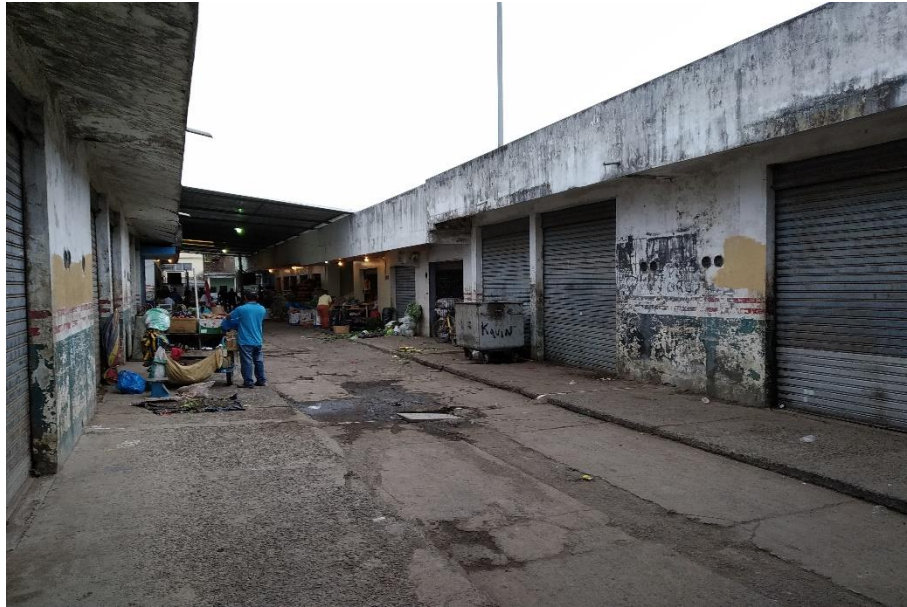
Gráfico No. 110. Imagen interna del areas de tiendas de expendios del Mercado Municipal N°2 de Portoviejo. Fotografía realizada por los autores de este análisis de caso. (2019).
