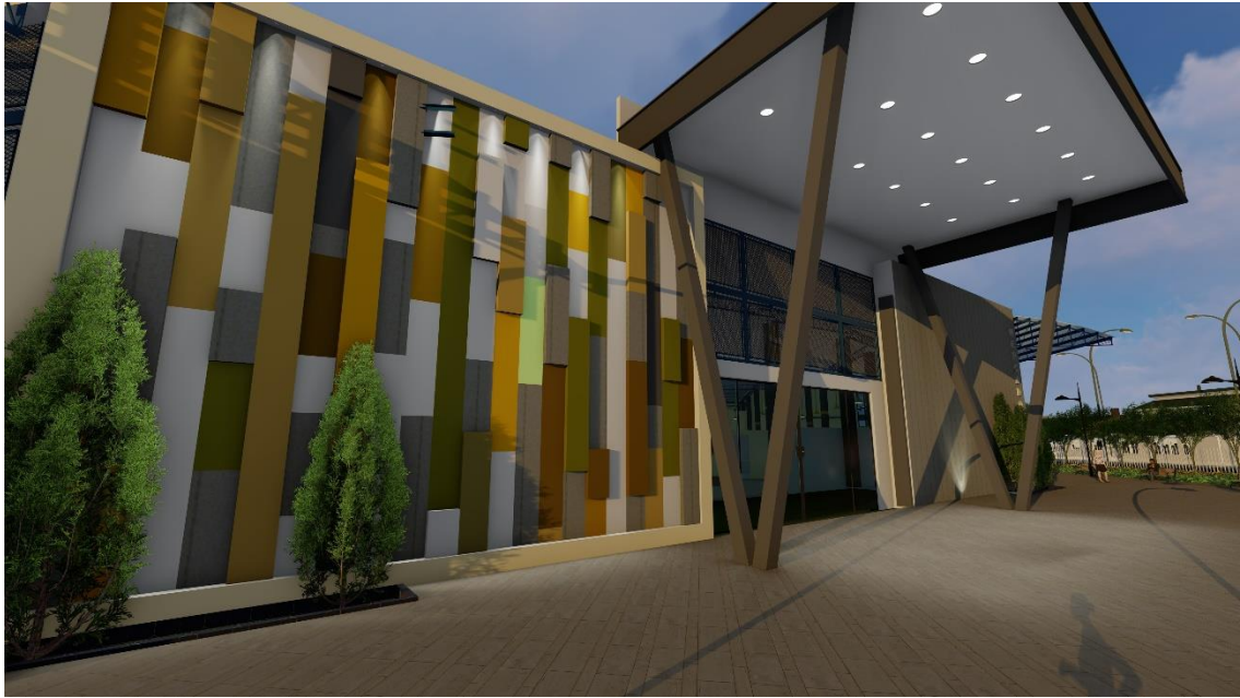
Gráfico No. 164. Fachada principal del nuevo Mercado Municipal Minorista n°2 de Portoviejo. República del Ecuador. Fotografía realizada por los autores de este análisis de caso. (2019).
