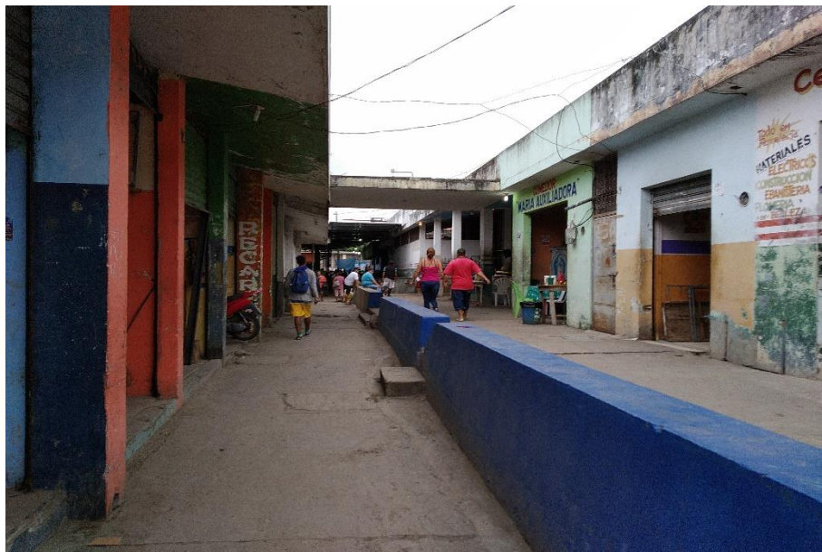
Gráfico No. 112. Imagen interna del areas de tiendas de expendios del Mercado Municipal N°2 de Portoviejo. Fotografía realizada por los autores de este análisis de caso. (2019).
