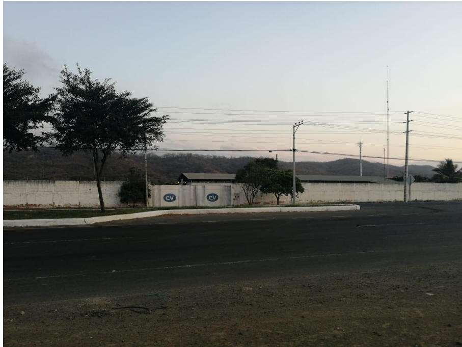
Gráfico No. 143. Vista de campo, terreno alternativa 2. Ciudad de Portoviejo. República del Ecuador. Fotografía realizada por los autores de este análisis de caso. (27, julio, 2019).
