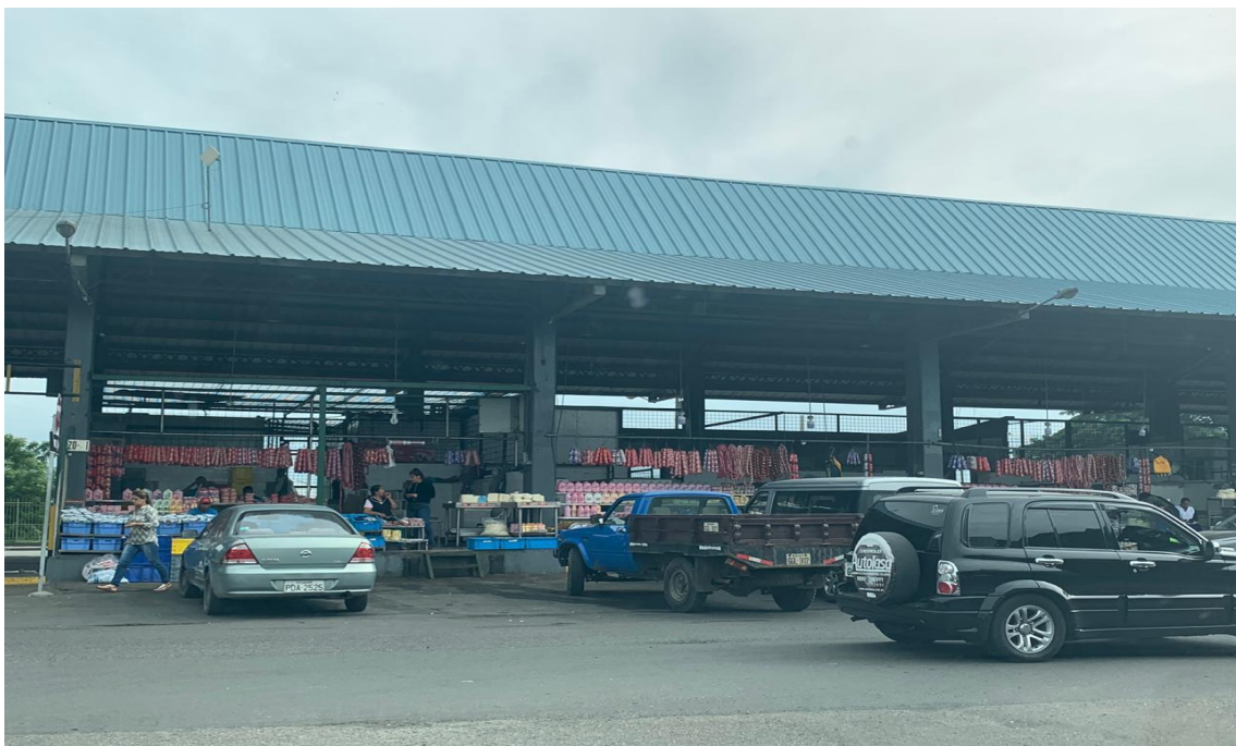
Gráfico No. 21. Vista general interna de la disposición de locales minoristas de la terminal de transferencia Montebello, cantón Guayaquil, provincia del Guayas. República del Ecuador. Fotografía realizada por los autores de este análisis de caso. (23, junio, 2019).
