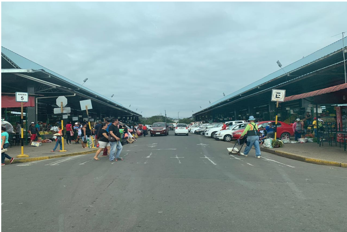
Gráfico No. 17. Vista general interna de la terminal de transferencia Montebello, cantón Guayaquil, provincia del Guayas. República del Ecuador. Fotografía realizada por los autores de este análisis de caso. (23, junio, 2019).
