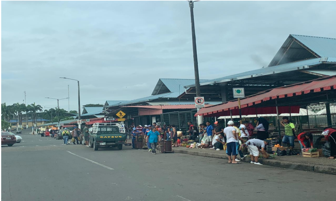
Gráfico No. 18. Vista general interna de la terminal de transferencia Montebello, cantón Guayaquil, provincia del Guayas. República del Ecuador. Fotografía realizada por los autores de este análisis de caso. (23, junio, 2019).
