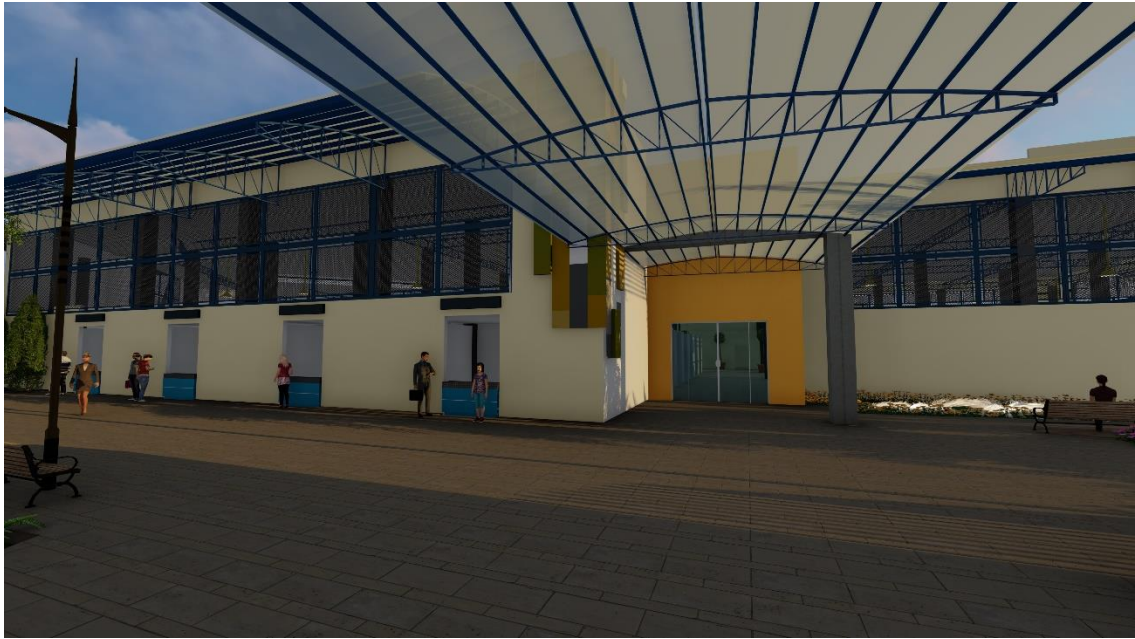
Gráfico No. 168. Vista exterior del nuevo Mercado Municipal Minorista n°2 de Portoviejo. República del Ecuador. Fotografía realizada por los autores de este análisis de caso. (2019).
