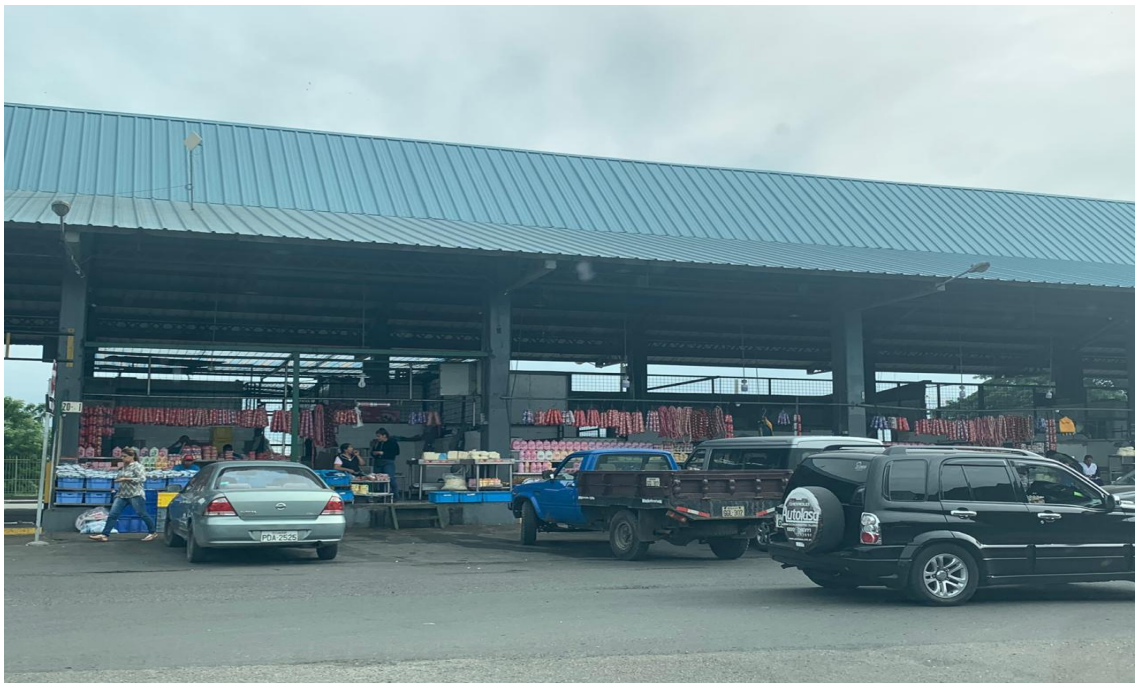
Gráfico No. 19. Vista general interna de la terminal de transferencia Montebello, cantón Guayaquil, provincia del Guayas. República del Ecuador. Fotografía realizada por los autores de este análisis de caso. (23, junio, 2019).
