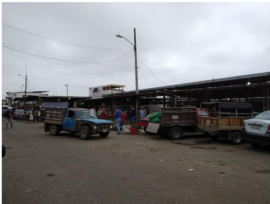
Gráfico No. 135. Vista de la fachada del Mercado Municipal N°2 de Portoviejo sobre la calle Venezuela. Fotografía realizada por los autores de este análisis de caso. (2019).
