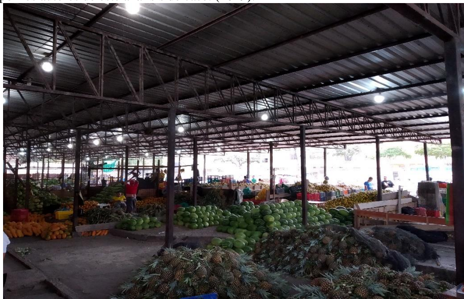
Gráfico No. 107. Vista interna de la zona de frutas del Mercado Municipal N°2 de Portoviejo. Fotografía realizada por los autores de este análisis de caso. (2019).
