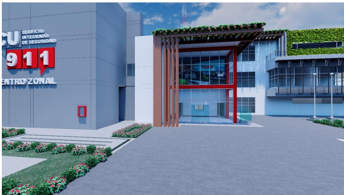
Gráfico No. 94. Fachada frontal del edificio ECU 911 con la intervención de pérgolas con vegetación y sistemas de fachadas Technal en carpintería de aluminio. Cantón Portoviejo. Provincia de Manabí. República del Ecuador. Fuente: Elaborado por los autores de este análisis de caso. [29, julio, 2019].
