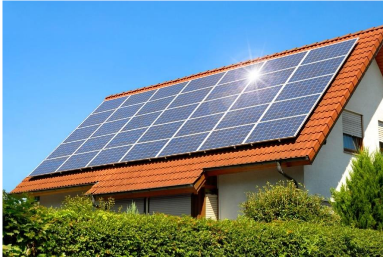
Gráfico No. 9. Paneles fotovoltaicos. Fuente: El periódico de la energía. [En Línea]. Consultado: [11, junio, 2019]. Disponible en: https://elperiodicodelaenergia.com/fuerteventura-dara-2-000-euros-por-instalar-paneles-fotovoltaicos-para-autoconsumo-en-viviendas/
