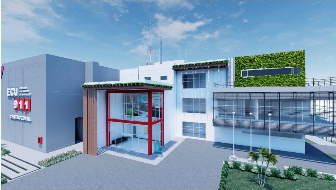
Gráfico No. 95. Fachada frontal del edificio ECU 911 con la intervención de pérgolas con vegetación y sistemas de fachadas Technal en carpintería de aluminio. Cantón Portoviejo. Provincia de Manabí. República del Ecuador. Fuente: Elaborado por los autores de este análisis de caso. [29, julio, 2019].
