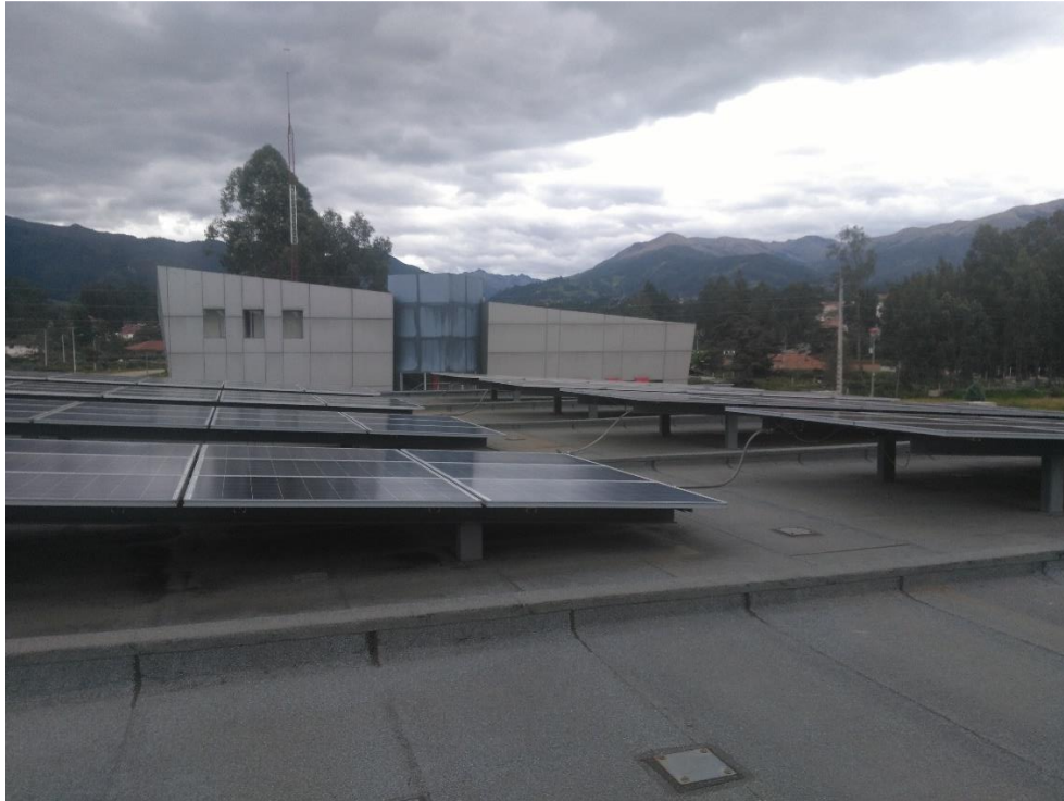
Gráfico No. 21. Paneles Fotovoltaicos rígidos instalados en serie y paralelo a un ángulo de inclinación de 5^{\circ} situados en la terraza del Centro de Energía Balzay de la Universidad de Cuenca. Cantón Cuenca. Provincia Azuay. (2019). Fuente: Fotografía realizada por los autores de este análisis de caso. [06, junio, 2019].
