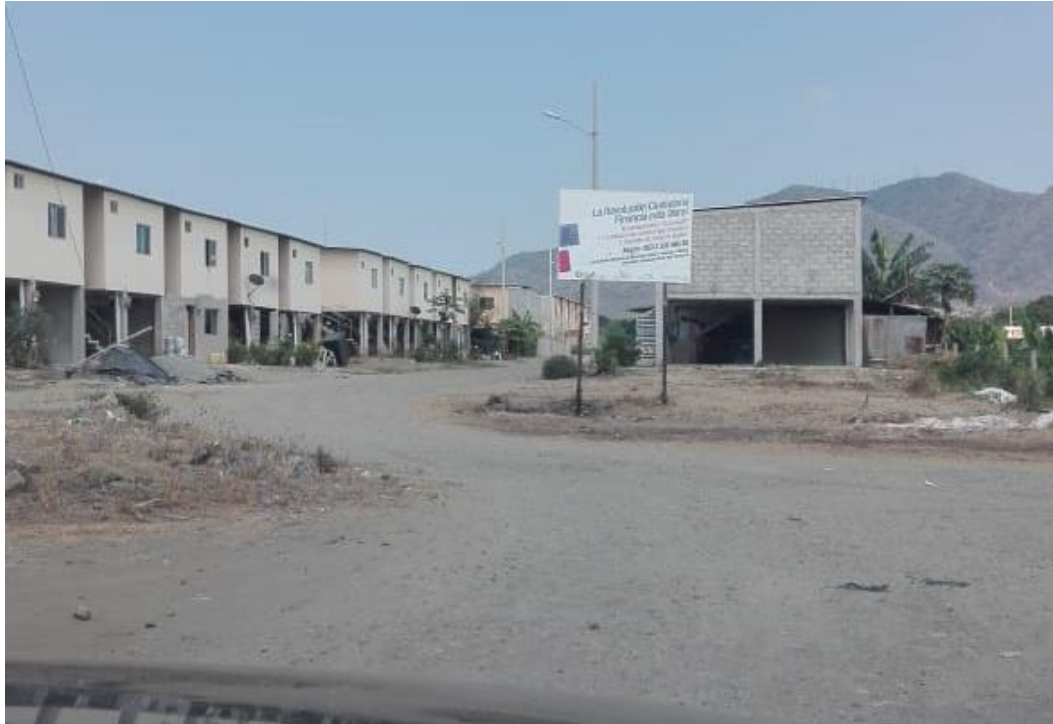
Gráfico No.8. Foto de estado actual del reasentamiento Picoazá III Fuente: Foto tomada por autoras del presente análisis de caso
