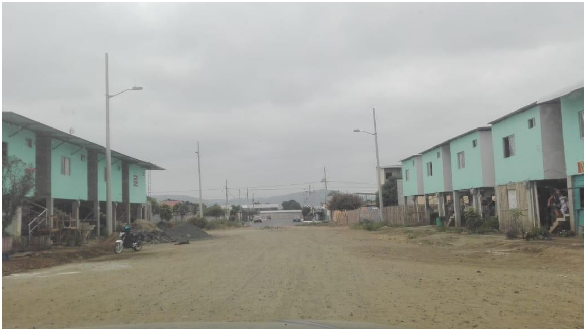
Gráfico No. 6. Foto de estado actual del reasentamiento Picoazá III Fuente: Foto tomada por autoras del presente análisis de caso
