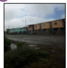
Vista de cajetines de agua servida
