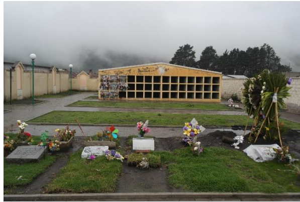
Gráfico No. 26. Reconstrucción del Cementerio de Lloa, Cantón Quito, Provincia Pichincha. Fuente: Fotografía tomada por los autores de este análisis de caso. [21, noviembre, 2018].
