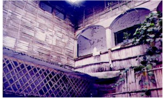
Gráfico N°. 79. Estado actual de las galerías que dan al patio interior
