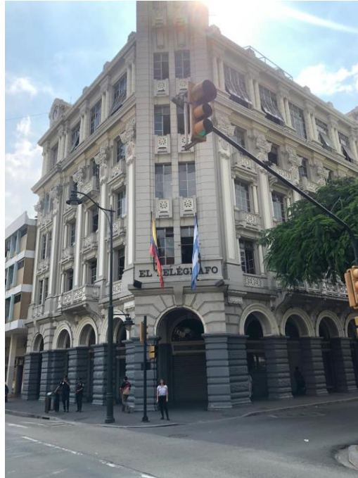
Gráfico 18. Edificio el Telégrafo (2019). ciudad de Guayaquil, República del Ecuador. Foto tomada por auxiliar de este análisis de caso.
