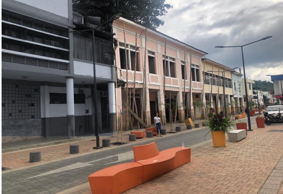
Gráfico 32. Viviendas patrimoniales a estudiarse estado post terremoto (2019). Cantón Portoviejo. República del Ecuador. Foto tomada por el auxiliar de este análisis de caso.
