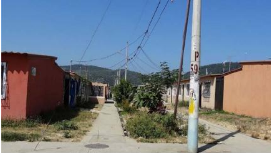
Gráfico No.28. Vista tipo del conjunto Socio Vivienda 2, Etapa 1.[En línea]. Consultado: [11, diciembre, 2018]. Disponible en: https://www.researchgate.net/publication/324570457_Bioclimatec_design_of_low_cost_housing_A_methodological_proposal_for_architecture_students_in_Guayaquil_Ecuador
