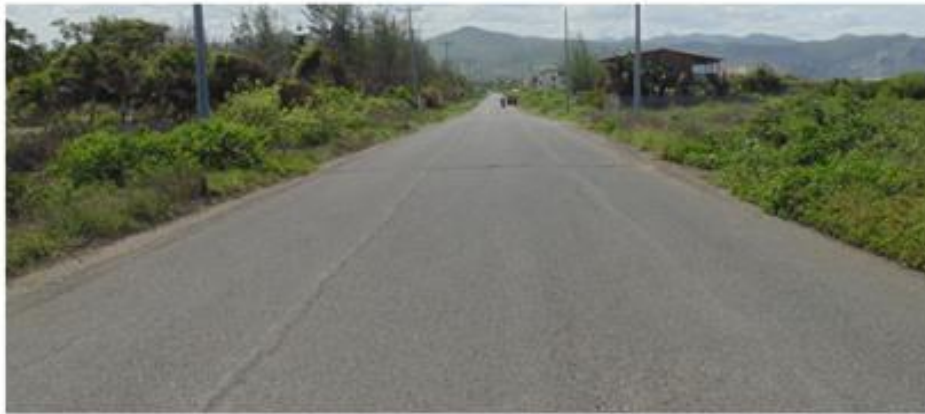
Inexistencia de aceras
