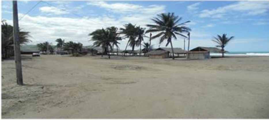
Inexistencia de aceras y tratamiento asfáltico
