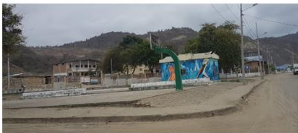
Mal estado de las aceras
