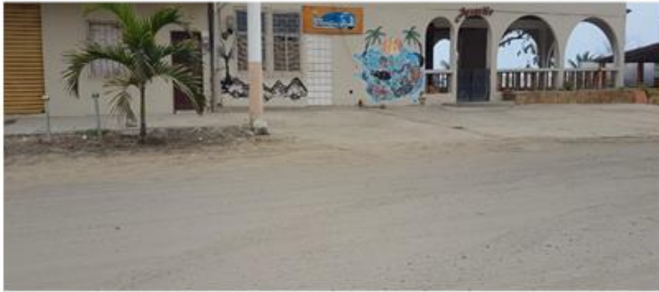
Mal estado de las aceras
