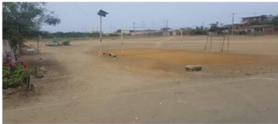
Inexistencia de aceras
