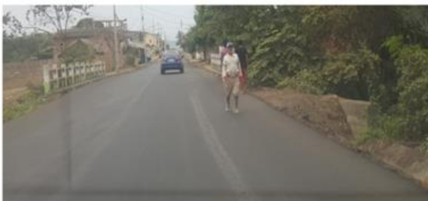
Falta de aceras
