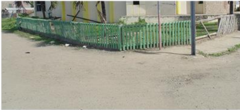
Inexistencia de aceras
