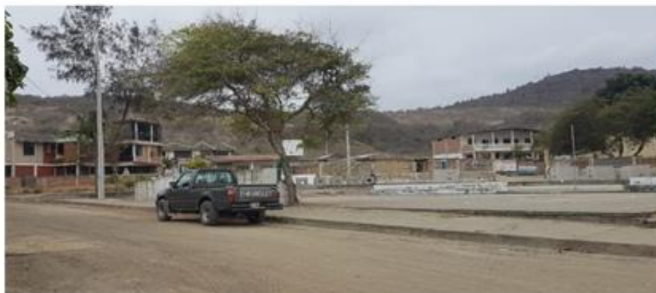
Cancha en mal estado
