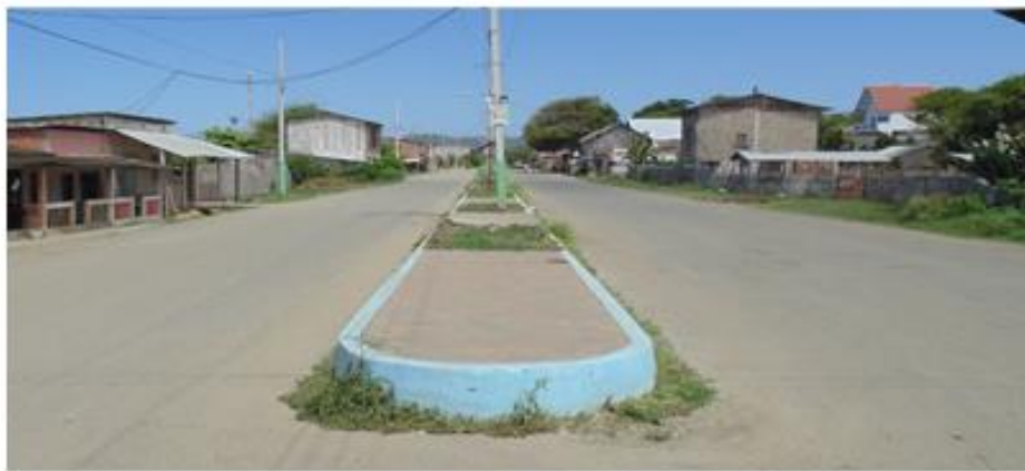
Inexistencia de aceras
