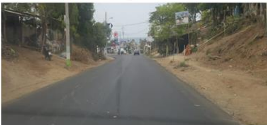
Falta de aceras
