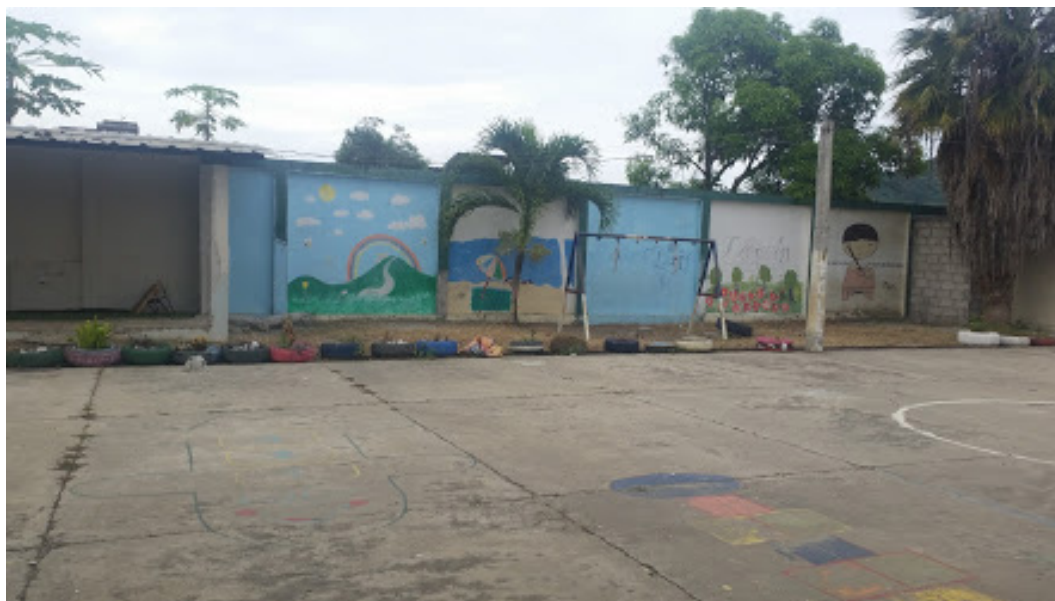
Imagen 31 Instalaciones de la Instiución
