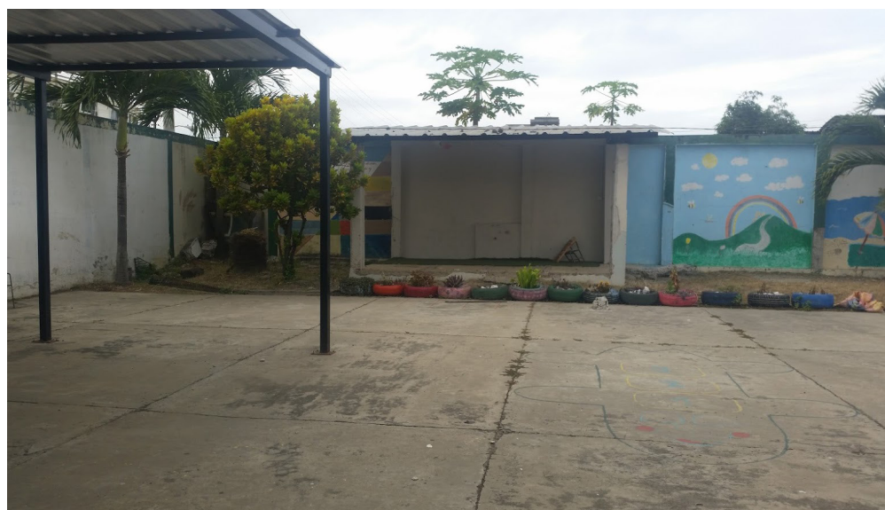
Imagen 33 Instalaciones de la Instiución
