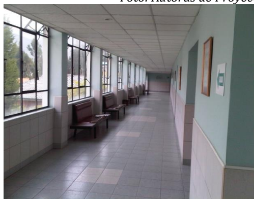
Ilustración 35. Pasillos internos S.C.
