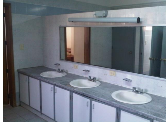
Ilustración 38. Baterías sanitarias – lavamanos S.C.
