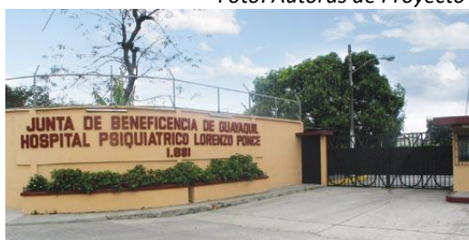
Ilustración 18. Hospital Psiquiátrico Lorenzo Ponce
