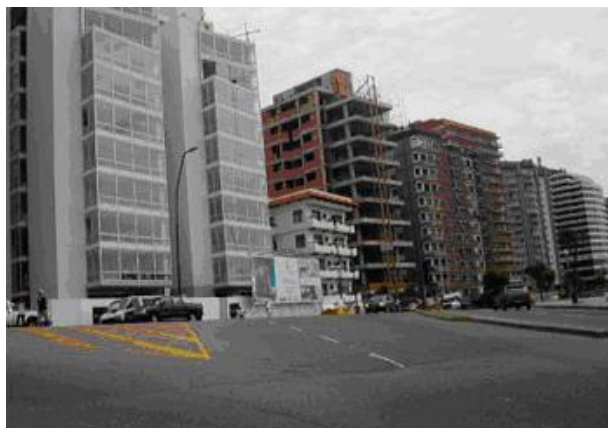
ILUSTRACION 105: Recientes emprendimientos inmobiliarios en altura en la costa. En este caso se trata del sector lindero con Playa Grande, donde el valor del suelo adquiere valores muy altos.
