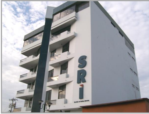
Ilustración 85: Edificio SRI Portoviejo
