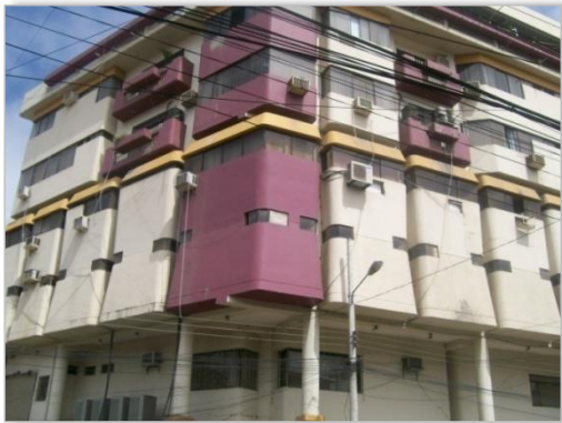
Ilustración 82: Edificio del IEESS Portoviejo
