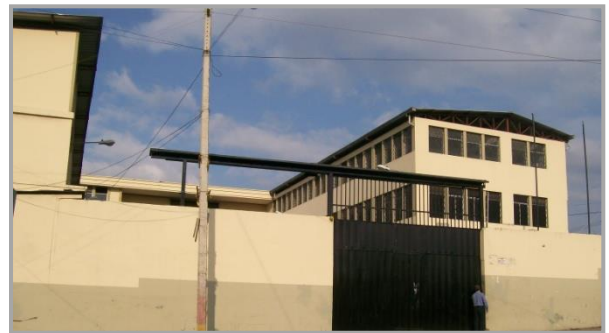
Ilustración 83: Edificio del TSE de Manabí
