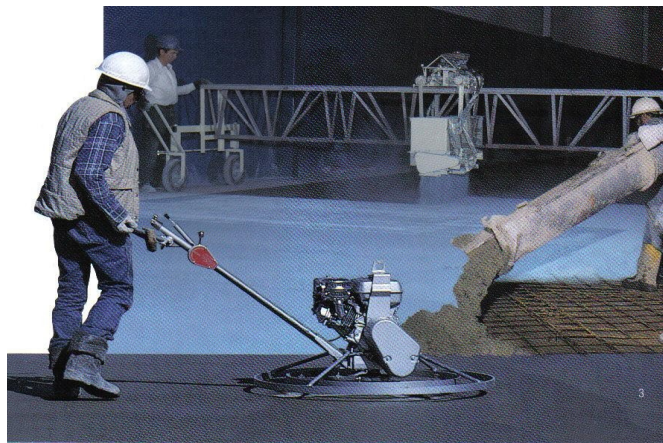
Ilustración 173: Aplicación de pisos epóxicos
