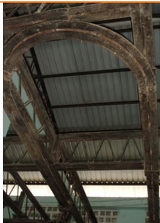
RIELES SIN FUNCIONAMIENTO
