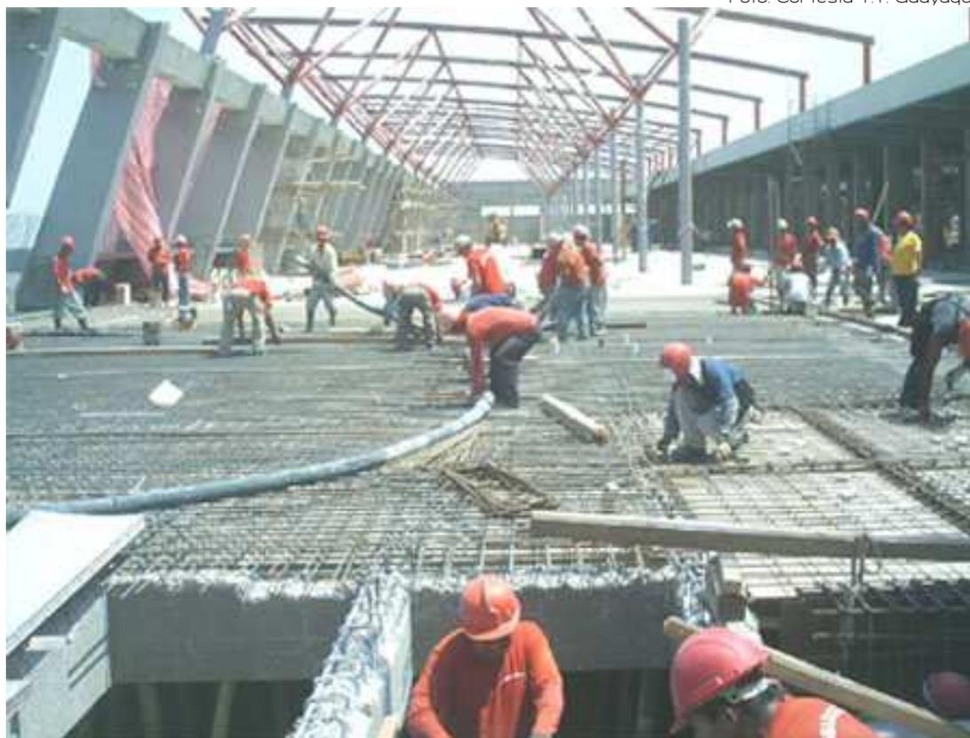
Ilustración 123: Fundición de las nuevas losas
