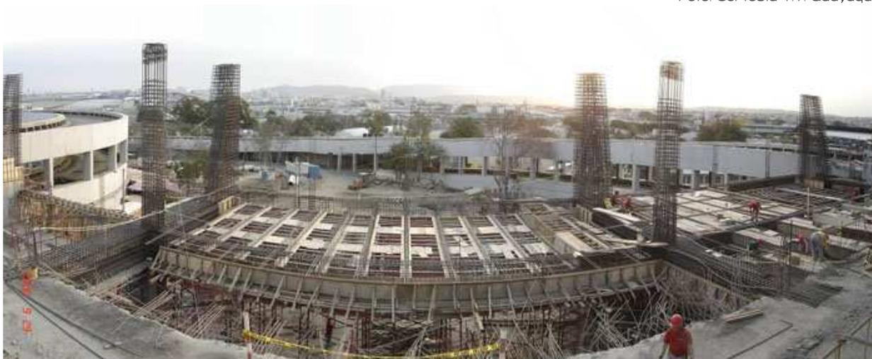
Ilustración 124: Proceso de armado de las losas
