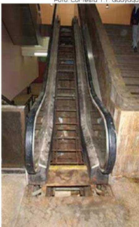
Ilustración 109: Escaleras mecánicas deterioradas
