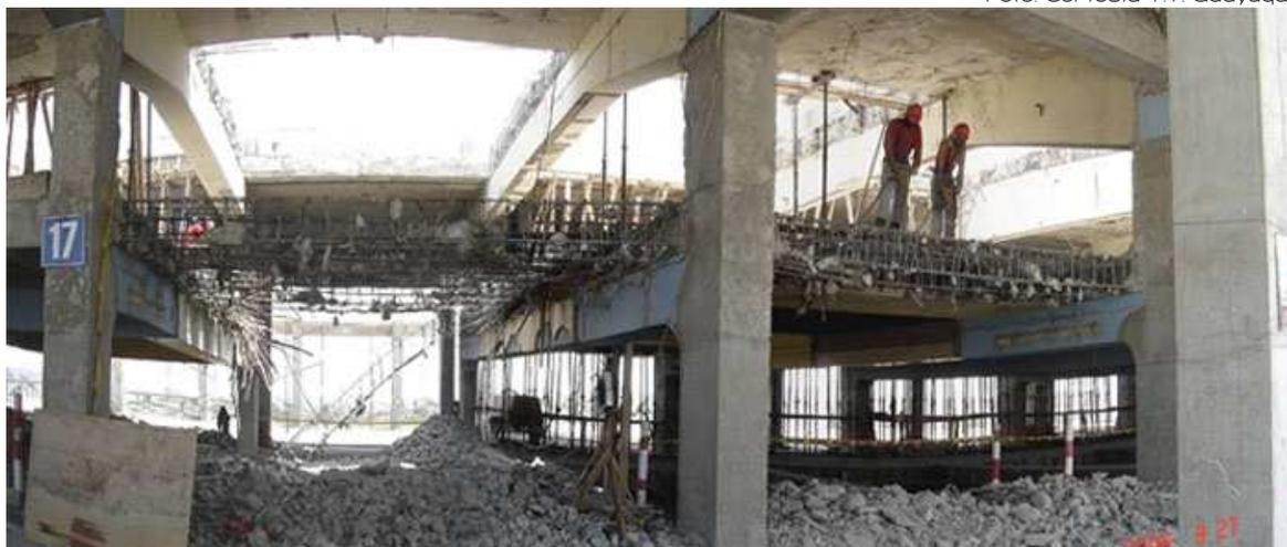
Ilustración 122: Proceso de demolición de losas
