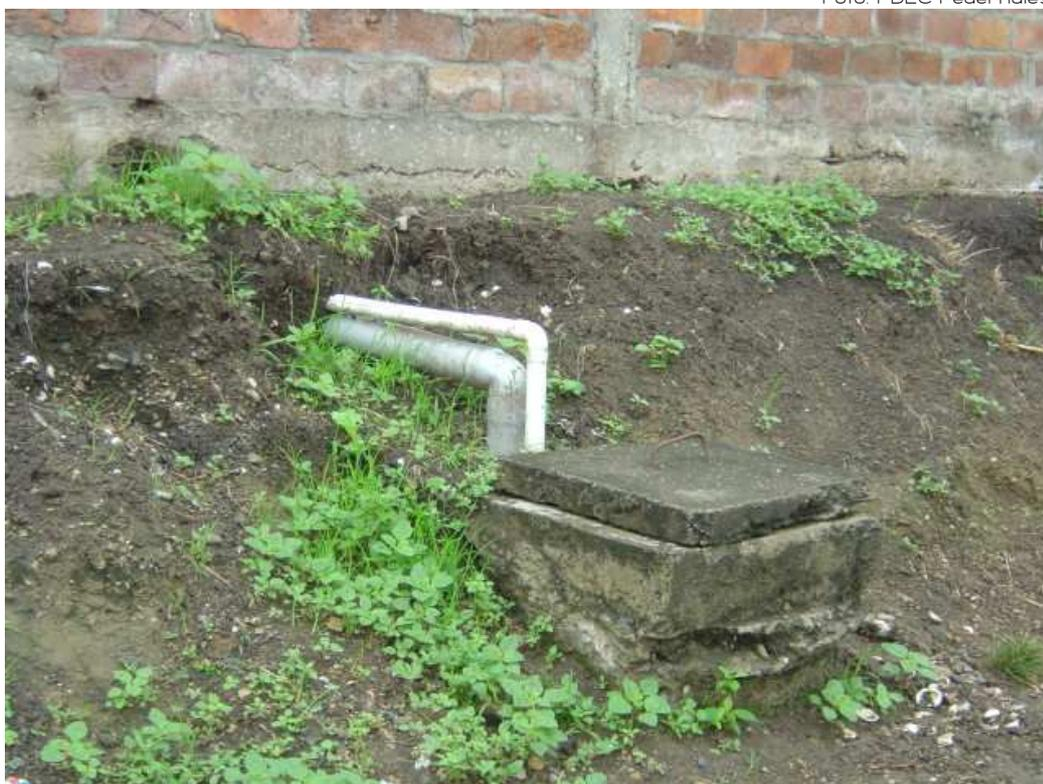
Ilustración 52: Caja de revisión del sistema de alcantarillado sanitario
