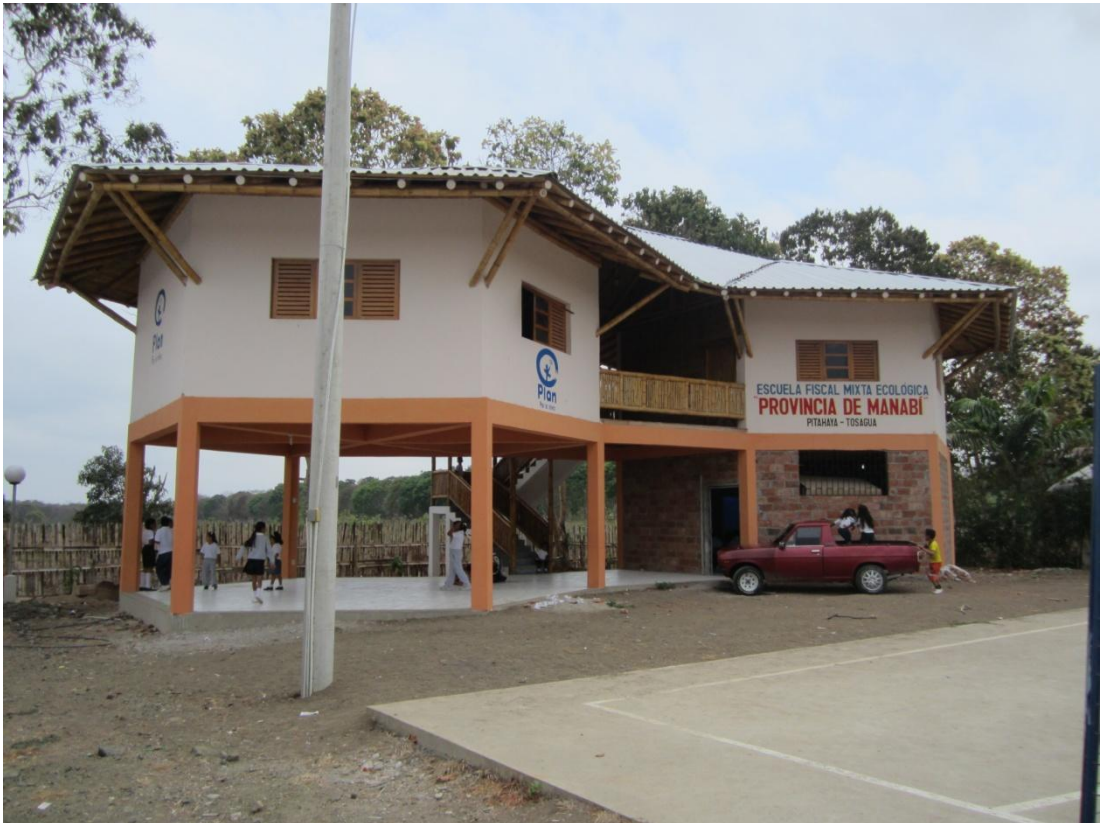
VISTA EXTERIOR DE LA INSTALACIÓN
