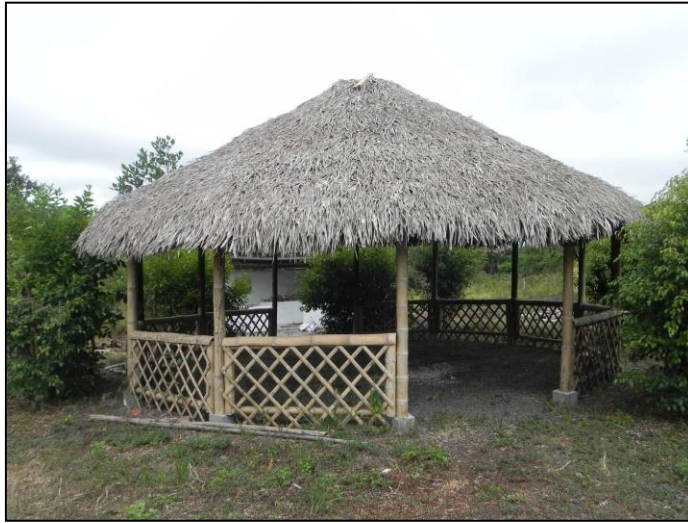
Fotografía 14 Construcción de madera existente junto a las oficinas del RVSMCP.
