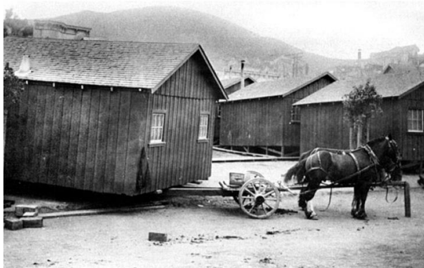
Gráfico No. 4. Cabañas y Sistema de Transporte utilizado PARA el terremoto de SAN FRANCISCO. Fuente: Fig. 33 Cabañas y Sistema de Transporte utilizado PARA el terremoto de SAN FRANCISCO. [En línea]. Consultado: [16, Mayo, 2018]. Disponible en: http://hdl.handle.net/2099.1/19614
